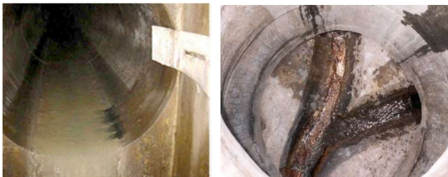
Abb. 1 – Kanalisationsschacht / Zusammenfluss zweier Leitungen
